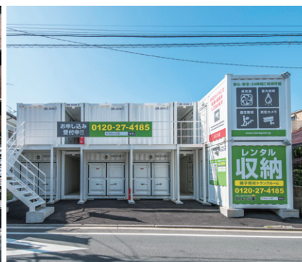
屋外型施設の外観
