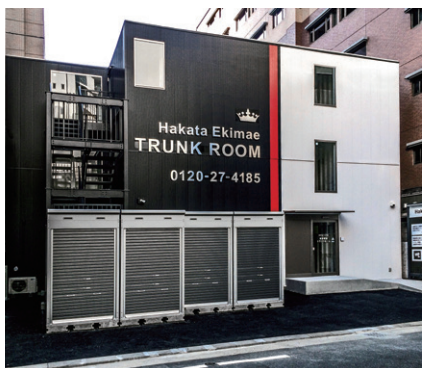
屋内型施設の外観
