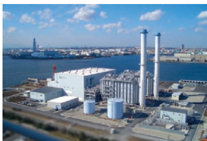
東京ガス・昭和シェル石油共同出資による火力発電所
