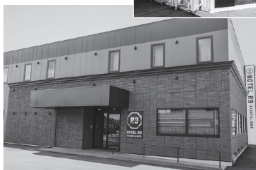
復興事業従事者向けの宿泊施設だったコンテナ建築物(写真上)をユニットのまま移動させ、コンテナホテルとして再生(写真左)〈写真提供: (株)デベロッパ〉
