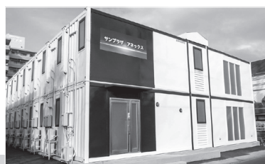
復興事業従事者向けの宿泊施設だったコンテナ建築物(写真上)をユニットのまま移動させ、コンテナホテルとして再生(写真左)〈写真提供: (株)デベロッパ〉
